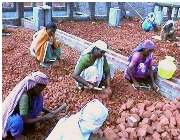
Arbeiterinnen bereiten die Abdeckung des Dachbodens vor.
