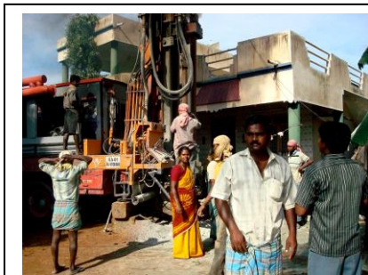
Wasserbohrung bei Kakangarai TN
